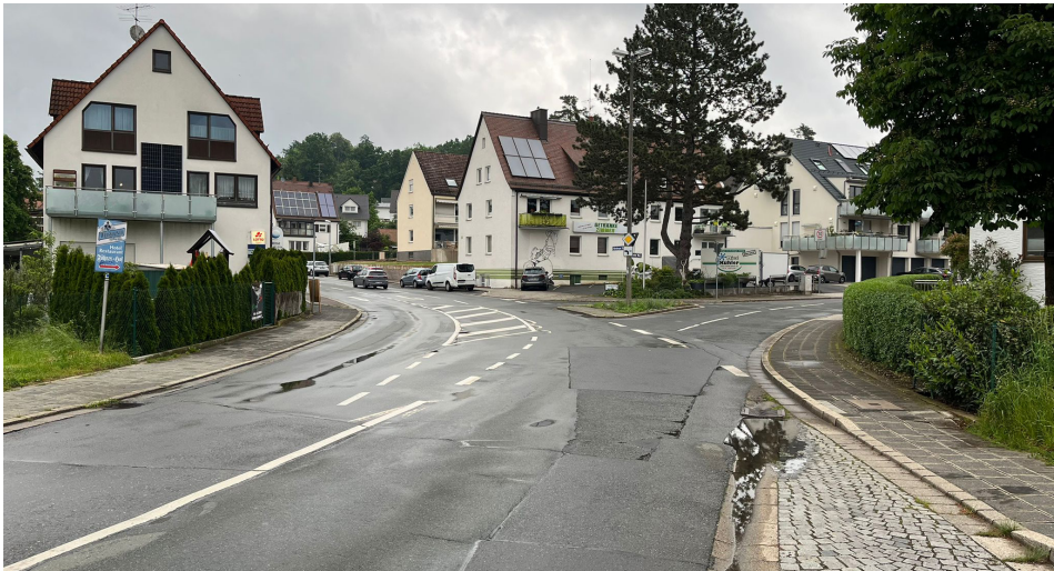
Im Bereich von Schreibwaren Reinfelder rollen demnächst die Bagger.
